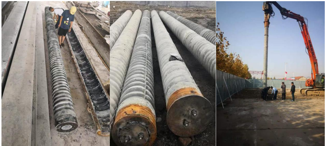
图 3 侧压增强桩工程应用
