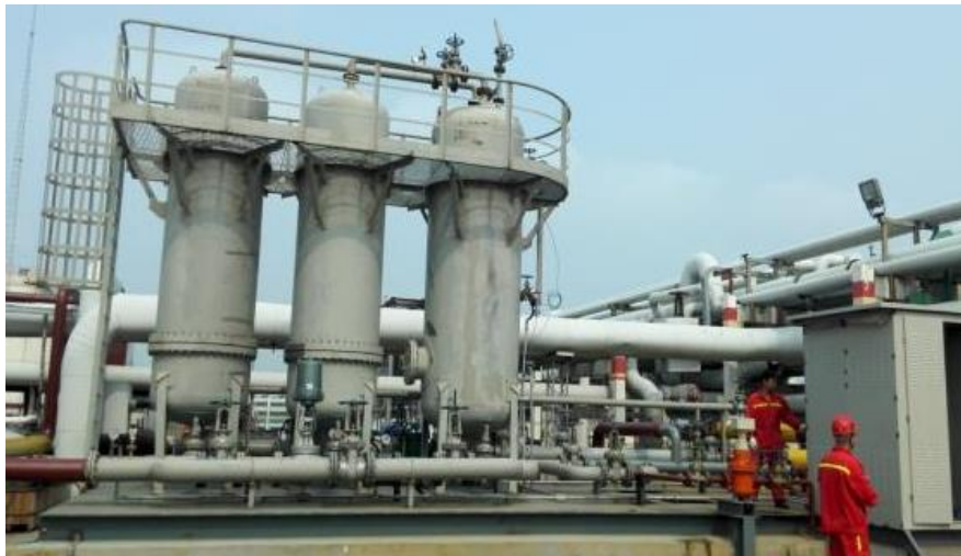
稠油采出液低温旋流脱水撬装装置
