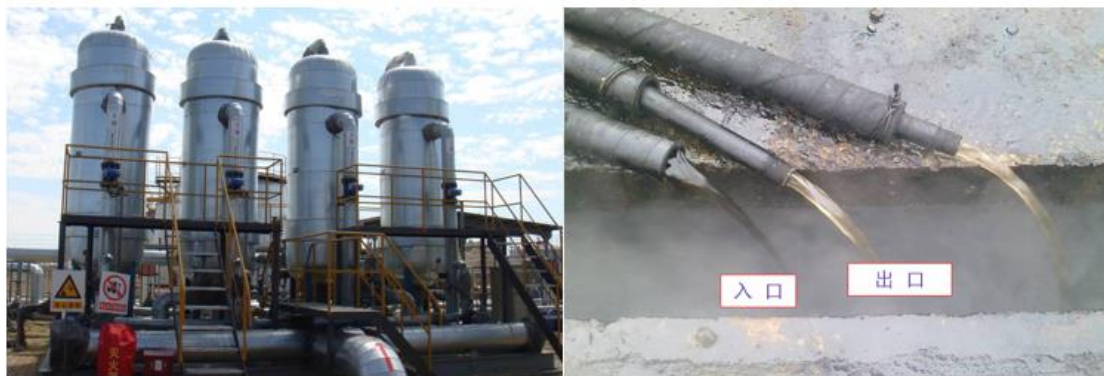
14000 方/天超稠油污水旋流聚结处理装置
