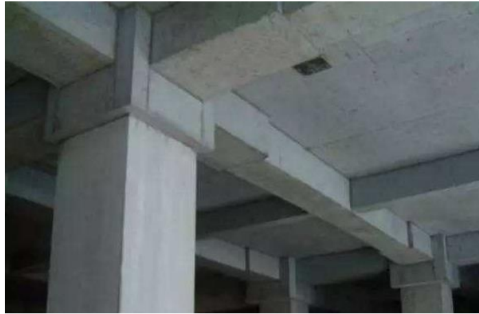
图 3 某建筑结构中的再生大骨料自密实混凝土梁
