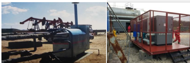
重力热管-高温空气源热泵联合加热装置（现场）
